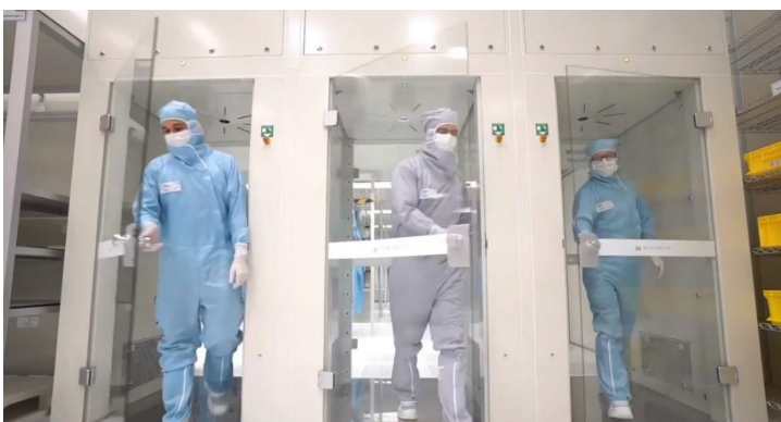
Bild 1: Personenschleuse für einen Reinraumbereich (Quelle: Zeiss SMT)
